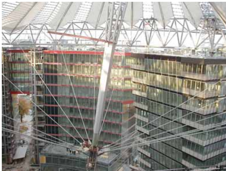
Bild 4. Luftstütze, unterer Teil
