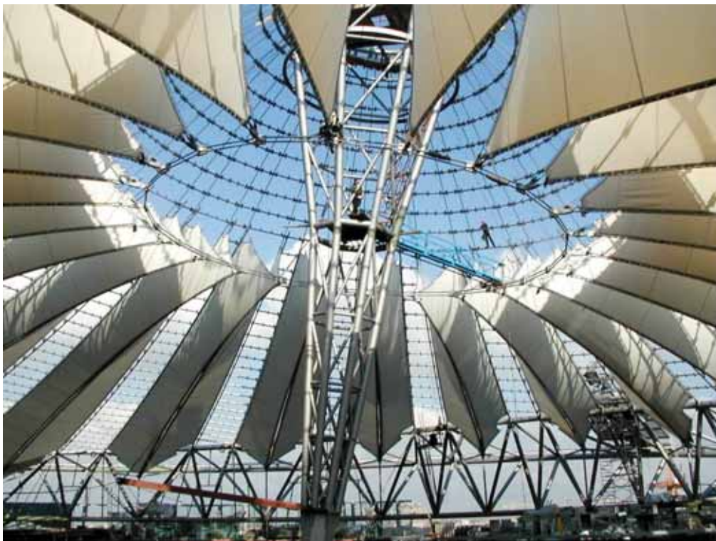
Bild 1. Untersicht des Forumdaches
