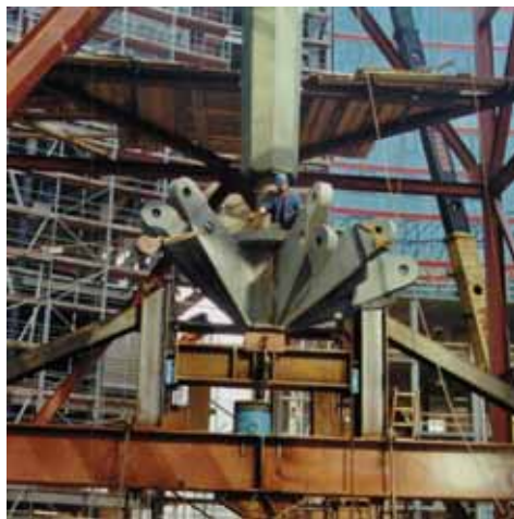
Bild 6. Fußpunkt der Luftstütze
