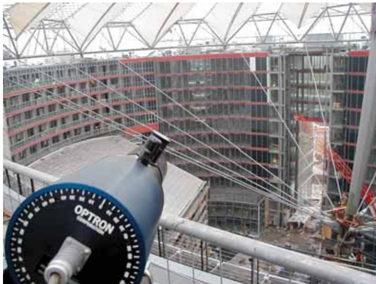
Bild 8. Blick vom Optron zu den Luftstützenseilen
