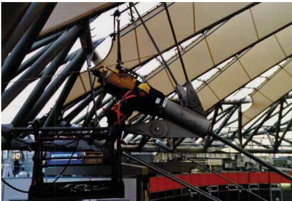
Bild 7. Hydraulische Presse am Luftstützenseil
